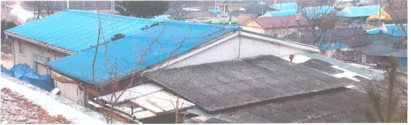
공사 전 양철지붕과 슬레이트
