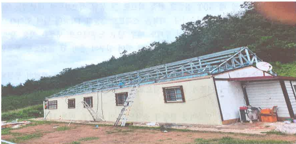
지붕 뼈대 설치
